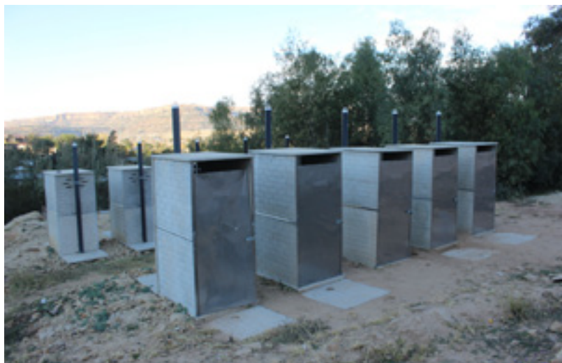
Nagelneue Toiletten für eine Schule in Lesotho
