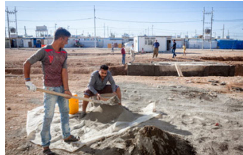
Aufbau einer sanitären Grundversorgung in einem kurdischen Flücht- lingslager, Irak 2018
