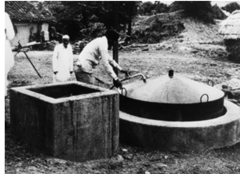
BORDA-Biogasanlage in Indien 1979
