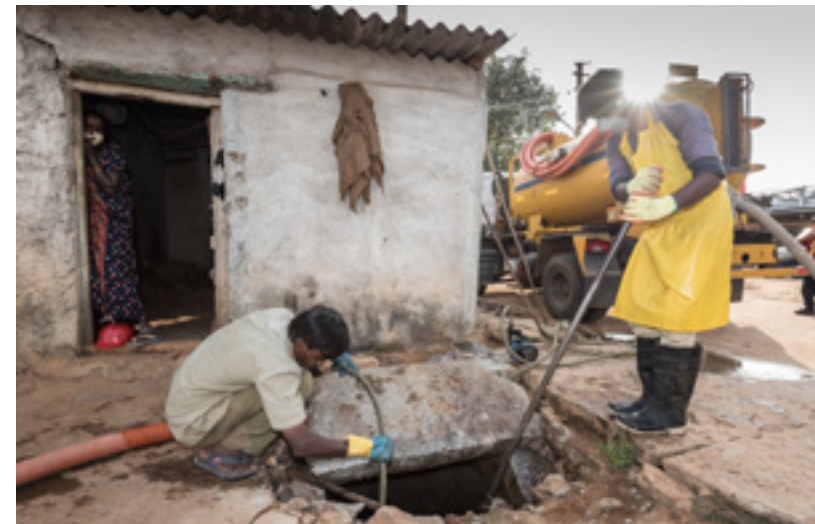
Auspumpen einer Fäkaliengrube in Devanahalli, Indien
