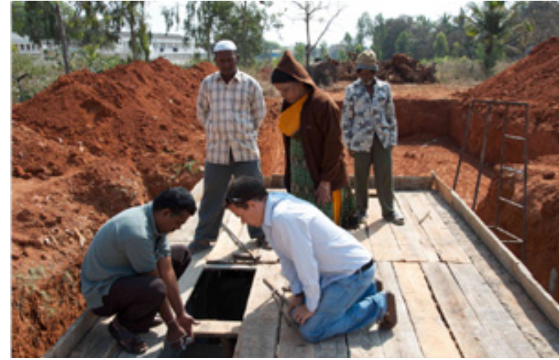
Einsatz in Bangalore, Indien: Konstruktion einer DEWATS-Anlage für ein Bauprojekt
