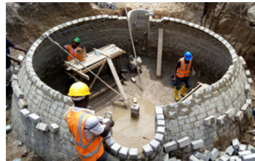
DEWATS-Anlage im Bau in Mbarahati/Tansania
