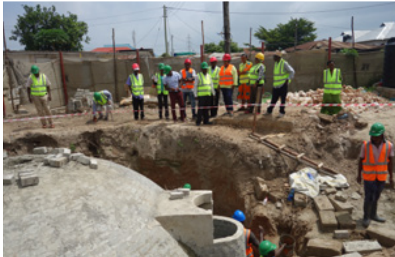
Bau einer DEWATS-Anlage in Daressalam/Tansania, 2015
