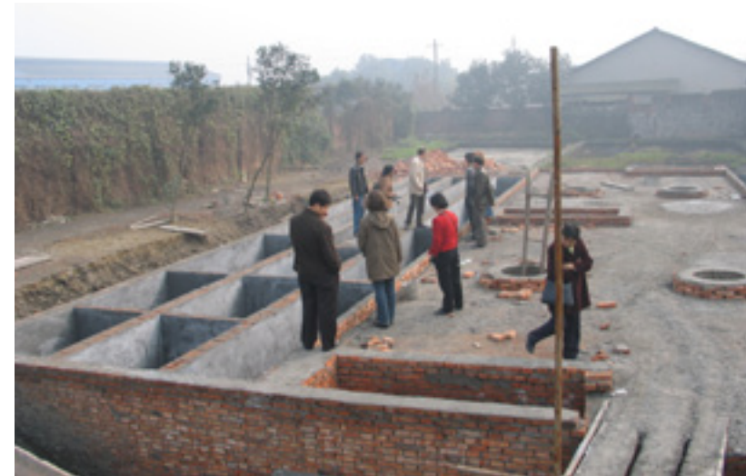
Bau einer DEWATS-Anlage, China 2004
