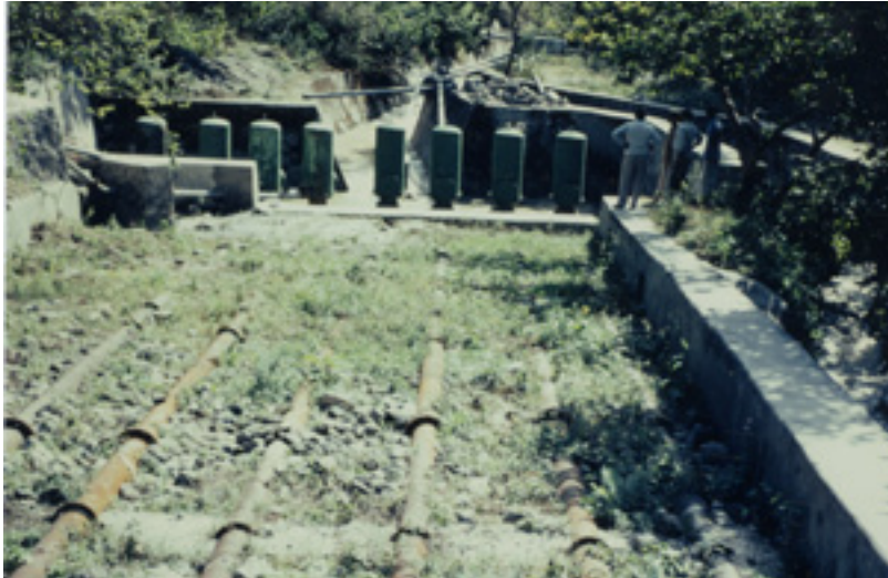
Großeinsatz Hydraulischer Widder, China 2002
