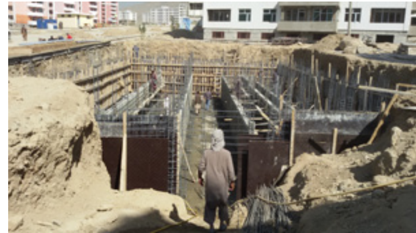
DEWATS-Anlage im Bau, Kabul/Afghanistan, 2014
