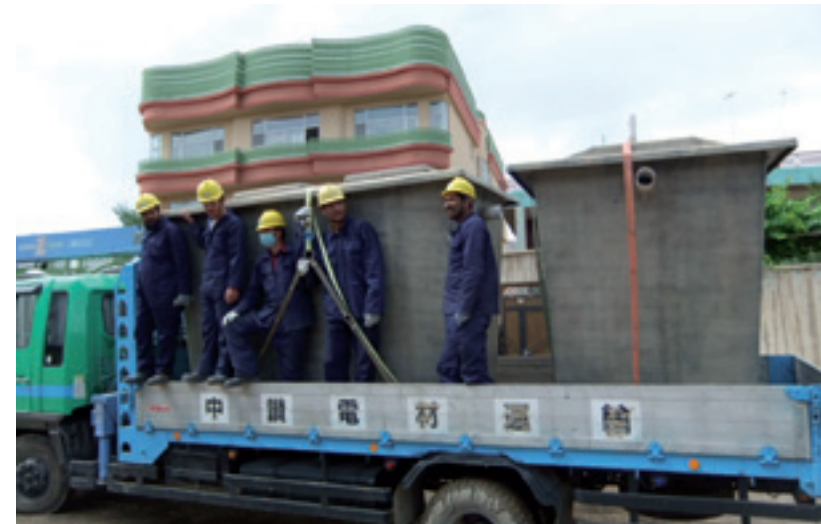
Vorgefertigte DEWATS-Module, Afghanistan 2013
