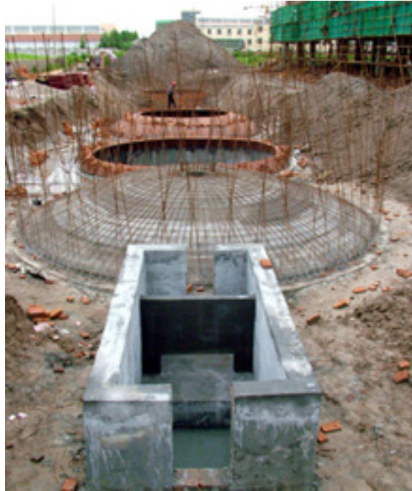
DEWATS-Anlage im Bau, China 2004
