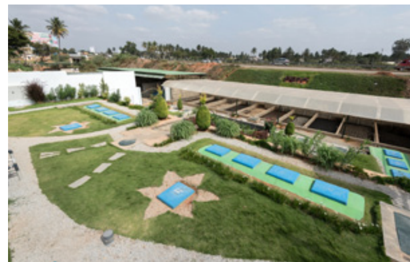
Fäkalschlamm-behandlungsanlage für 30.000 Menschen in Davanahalli/Indien
