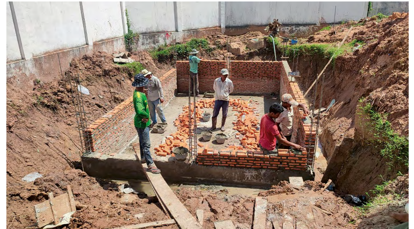
Kambodscha: Die Bauarbeiten für das DEWATS-Projekt an der öffentlichen Oberschule im Zentrum der Stadt Kratie begannen im Juni und wurden im Oktober 2022 abgeschlossen. Der Betrieb des DEWATS-Systems wurde im November 2022 aufgenommen. Die Reinigungskapazität des Systems beträgt 6 Kubikmeter pro Tag, und es sammelt alle Abwässer aus den Toiletten und Büros der Schule.
