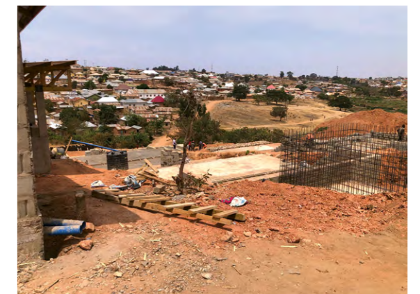
Tansania: Bauliche Umsetzung einer Fäkalschlammbehandlungsanlage in der Stadt Korogwe, Tansania
