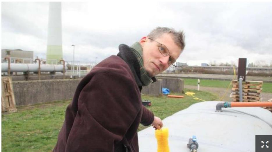
Kristian Franzius, Ingenieur bei Borda, zieht einen Filter aus dem Abwasserausgang des faltbaren Klärbehälters „Septic Bag“ (der graue Tank). - Foto: Kowalewski
