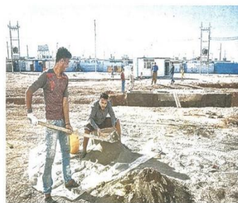
Bau eines dezentralen sanitären Systems im Irak.
