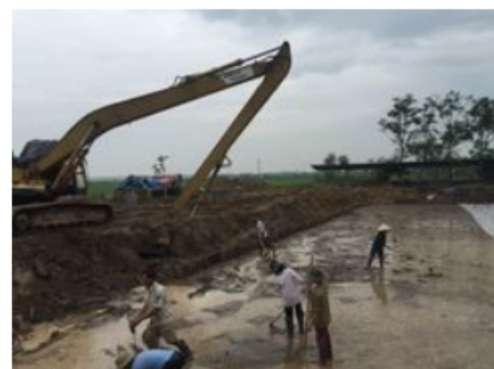
Bau der DEWATS-Anlage in Khac Niem
