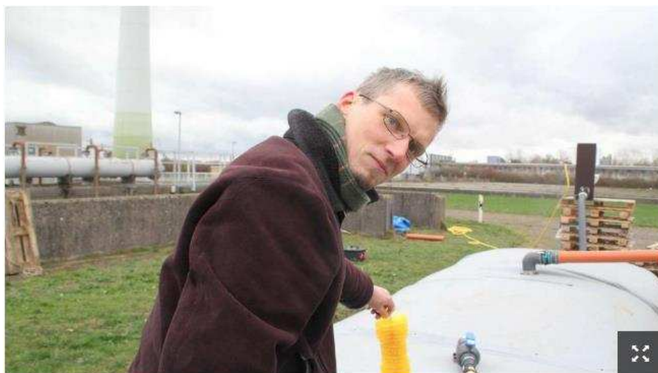
Kristian Franzius, Ingenieur bei Borda, zieht einen Filter aus dem Abwasserausgang des faltbaren Klärbehälters „Septic Bag“ (der graue Tank). • Foto: Kowalewski
