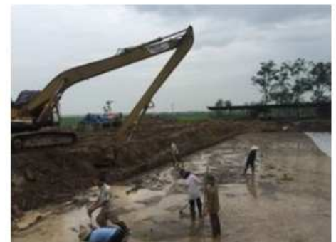
Bau der DEWATS-Anlage in Khac Niem
