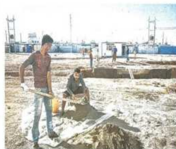
Bau eines dezentralen sanitären Systems im Irak.
