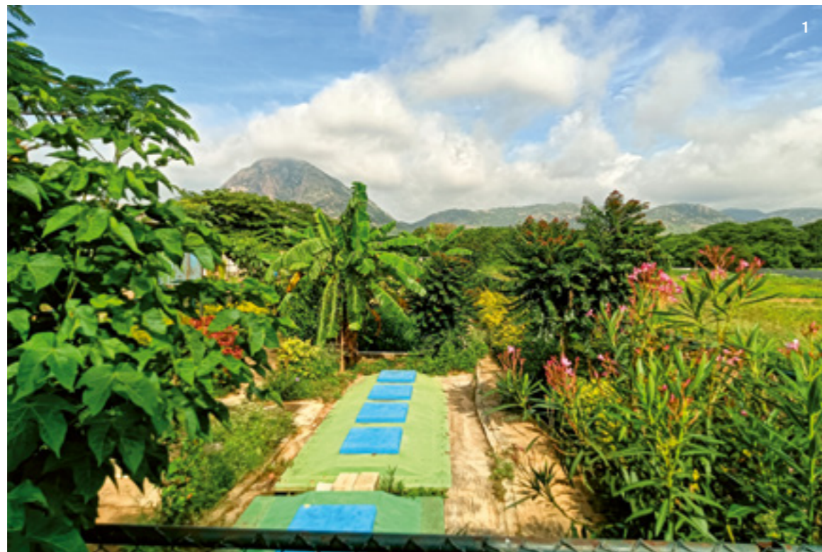
1 Indien: DEWATS in der Kandawara- Siedlung in Karnataka
