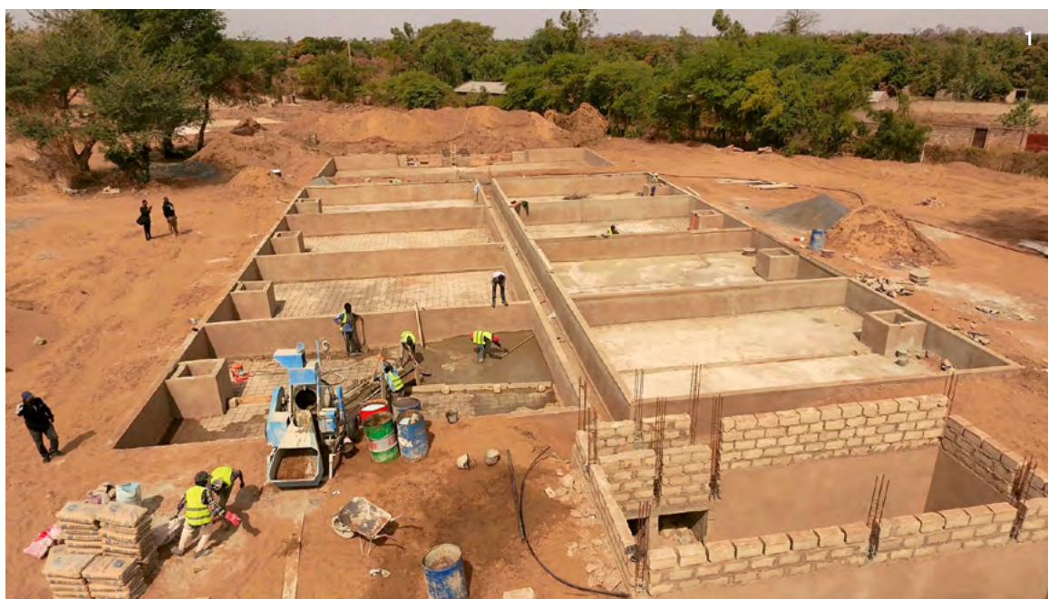
1 Senegal: Bauphase der Fäkalschlamm- aufbereitungsanlage in Thiès
