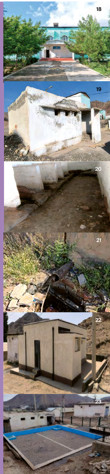
18 Verbesserte sanitäre Einrichtungen für ein gesünderes Schulumfeld 19 Außentoilette (vorher) – Außenansicht 20-21 Abwasserableitung (vorher) 22 Renovierte Toilette 23 Kläranlage
