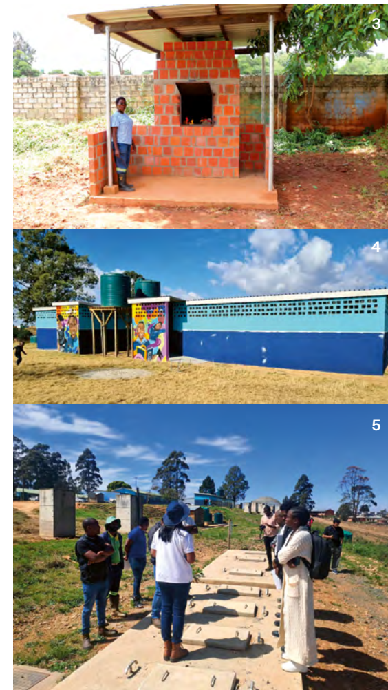
3 Sambia: Verbrennungsanlage für Hygieneartikel an der Chelston Secondary School in Lusaka.
